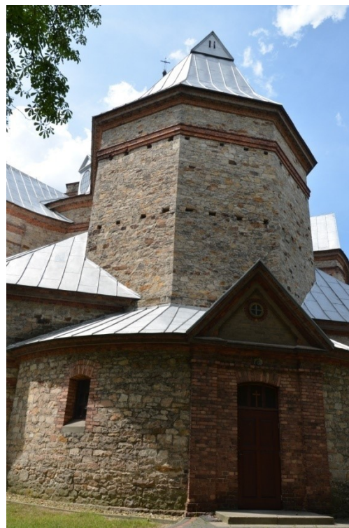
Fot. 4. Falków. Kościół p.w. Trójcy Świętej, widok od wschodu (fot. J. Nawrot-Bukowiec).
