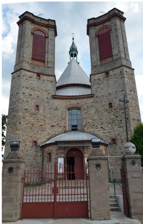
Fot. 3. Falków. Kościół p.w. Trójcy Świętej, widok od zachodu (fot. J. Nawrot-Bukowiec).
